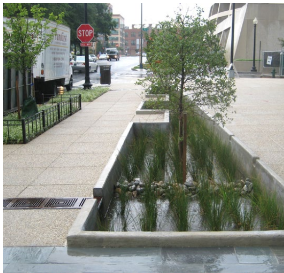
Rysunek 9. Ogród deszczowy w pojemniku: Waszyngton, Stany Zjednoczone (po lewej); przy budynku InfoBox w Gdyni, Polska (po prawej)
