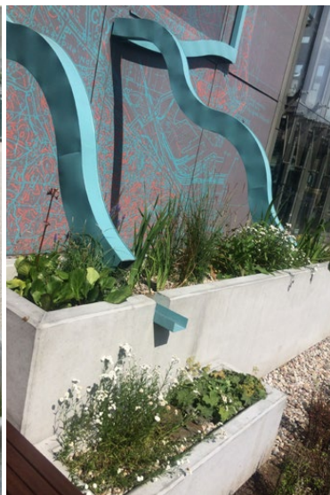
Rysunek 9. Ogród deszczowy w pojemniku: Waszyngton, Stany Zjednoczone (po lewej); przy budynku InfoBox w Gdyni, Polska (po prawej)
